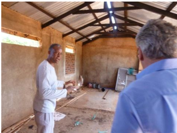
Father John zeigt den Kindergartenrohbau
