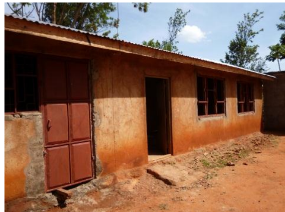
Außenansicht vor der Fertigstellung
